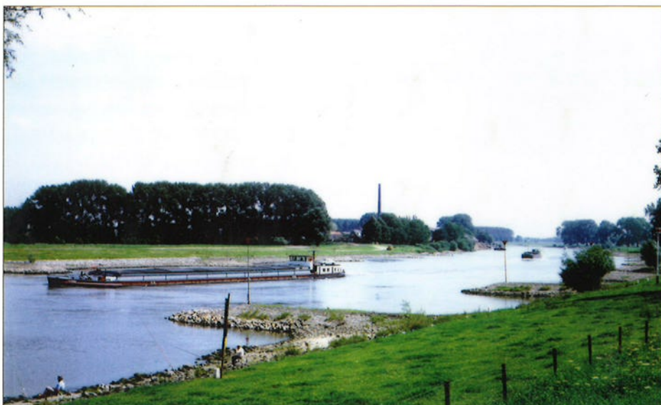
Om de rivieren op diepte te houden zijn strekdammen aangelegd. De stroom blijft dan in het midden van de rivier.
